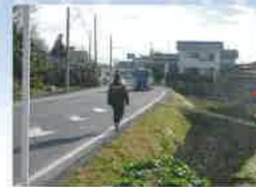
歩道整備前と整備後の県道鴻巣川島線
