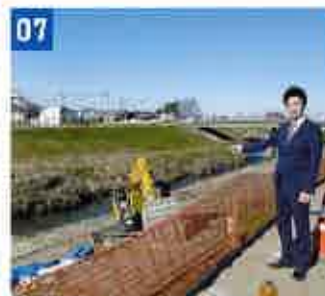
07 新河岸川護岸・堤防
