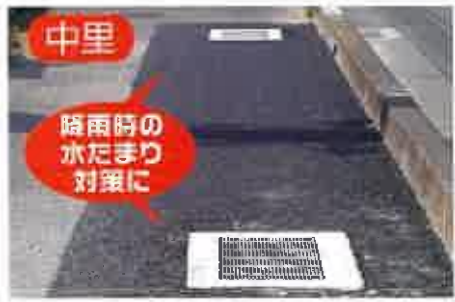
排水マスの新設
