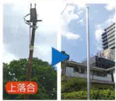
古い街路灯を新しく! 老朽化、折れる前に交換
