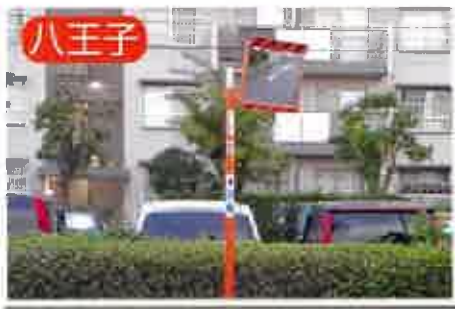
カーブミラー新設
