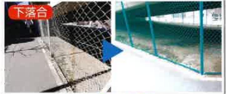
老朽鉄柵修繕
