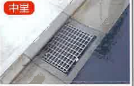
排水マスの堆積土砂の撤去
