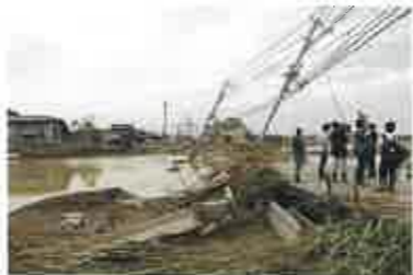
平成27年9月、鬼怒川水害現場（茨城県常総市）にて。電柱が倒れると救助・復旧活動の支障になる。
