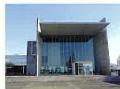
▲埼玉県環境科学国際センター展示館「彩かんかん」の外観(加須市上種足914)
