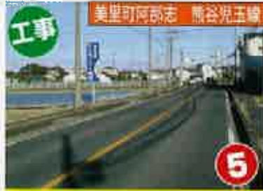
美里町阿部志 熊谷児玉線 傷んだ舗装を修繕します
