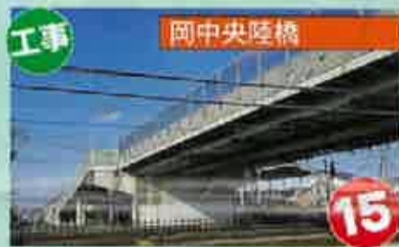
落橋防止のため橋りょうを整備します（針ヶ谷岡線）
