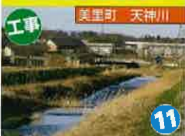
美里町天神川 河川を改修します
