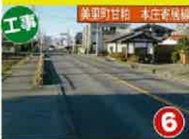
美里町甘粕 本庄寄居線 傷んだ舗装を修繕します
