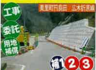
美里町戸良田 広木折原線 道路環境を整備します
