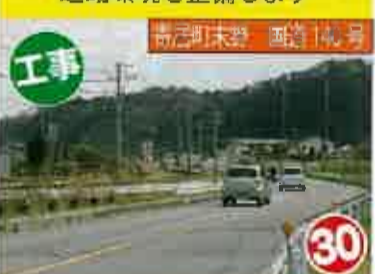
寄居町末野 国道140号 安全に通行できる道路を作ります
