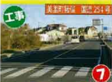
美里町岩保 国道254号 道路環境を整備します
