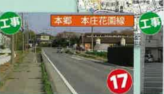
傷んだ道路を舗装します
