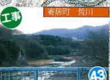
寄居町 荒川 河川を改修します
