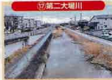
17 第二大堀川 測量設計(橋梁建設機材)
