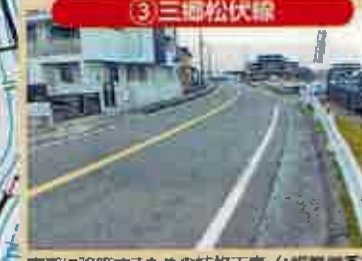
3 三郷松伏線 市道に移管するための補修工事・台帳整備委託
