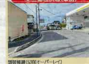
6 三郷松伏線(幸房) 舗装修繕(切開オーバーレイ)
