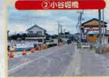
2 小谷堰橋 仮歩道橋の工事及び借地・移設補償
