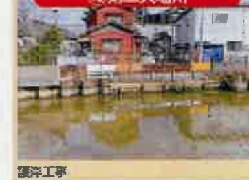
12 第二大堀川 護岸工事
