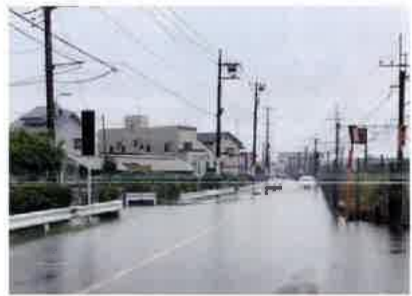
6月の大雨による内水氾濫被害の様子(半田地区)
