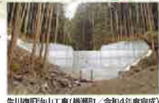
生川復旧治山工事(横瀬町/令和4年度完成)
