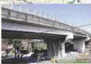
⑨下加治高架橋(橋りょう修繕)
