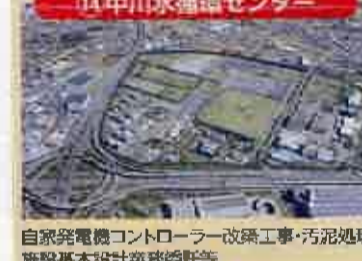
14 中川水循環センター 市役所 最新都市 設計事務所 自家発電機コントローラー改築工事・汚泥処理施設基本設計業務委託等
