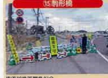
15 駒形橋 橋梁架換工事負担金
