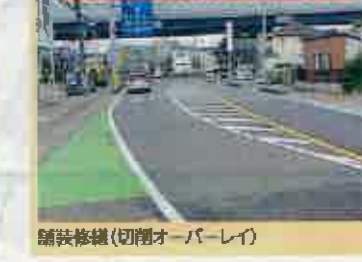
9 松戸草加線(高州4丁目) 舗装修繕(切開オーバーレイ)
