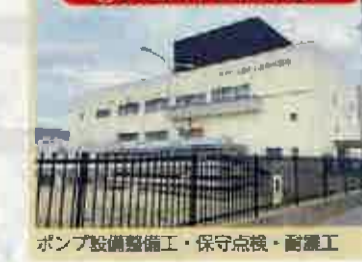
8 大堀川下流排水機場 ポンプ設備整備工・保守点検・耐震工
