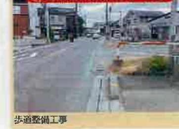
11 葛飾吉川松伏線(戸ヶ崎) 歩道整備工事
