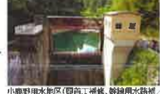
小鹿野用水地区(観音工補修、幹線用水路補修)令和4年度完成)県営かんがい排水事業
