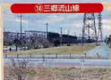
16 三郷流山橋 鉄塔移設の設計に対する東京電力への負担金
