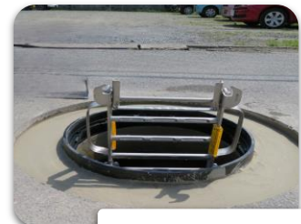
SFモルタル仕上げ
