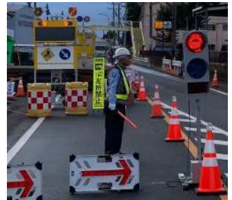
信号機システムを導入した現場の様子
