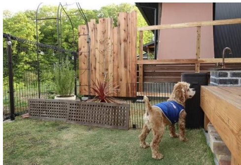
施工事例②
