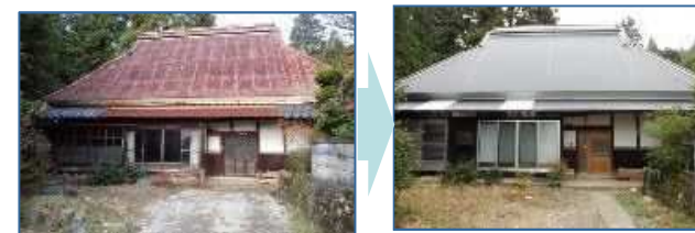
地域活性化のため、空き家を地域交流施設に活用
