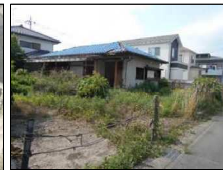
適切に管理されていない空家等 (雑草が繁茂、屋根の一部が欠損)
