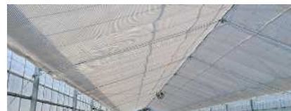
栽培施設の遮光資材整備
