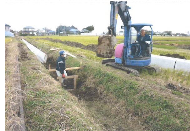
水路の整備 (施工中)
