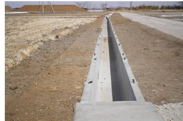
水路の整備 (完成)
