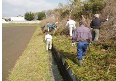
水路の泥上げ
