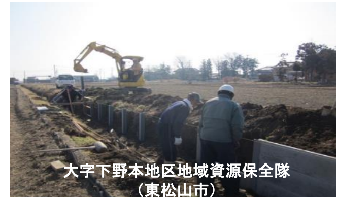
水路の大規模補修（土留設置）
