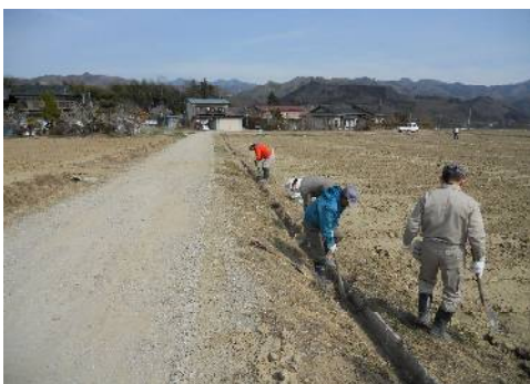
(開水路の泥上げ作業)
