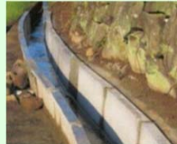
コンクリート水路の更新
