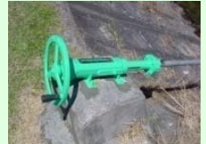
ゲート・バルブの更新
