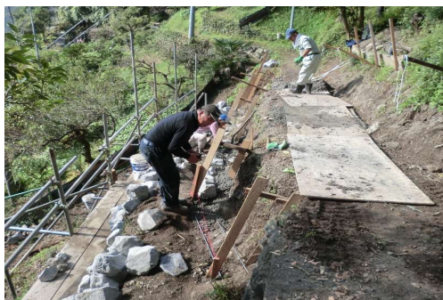
農用地法面の石積み施工作業の様子
