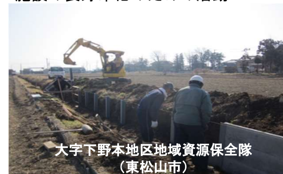
水路の大規模補修（土留設置）
