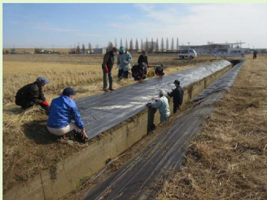
防草シートの設置
