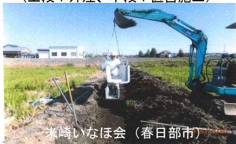
水路の補修工事 (上段：外注、下段：直営施工)
