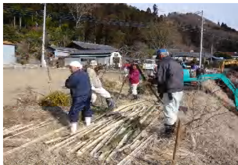
共同作業による復旧作業 (秩父市布里田中地区)
