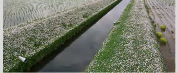
きめ細やかな雑草対策対策 水路法面へのヒメイワダレ草の植栽 （加須市種足地区）
