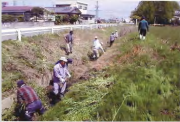
水路の泥上げ（熊谷市太田中部地区）
