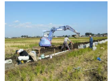
水路敷設工事
