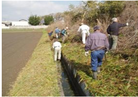
水路の泥上げ
