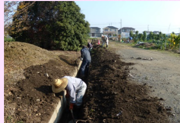
水路の泥上げ
