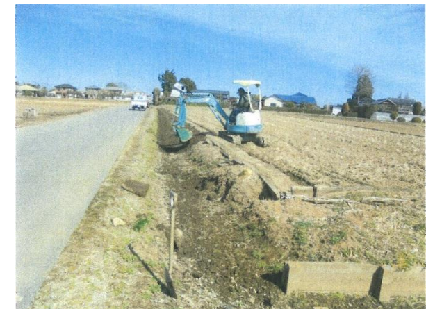
水路浚渫工事
