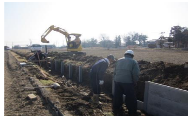
水路の大規模補修（土留設置）
