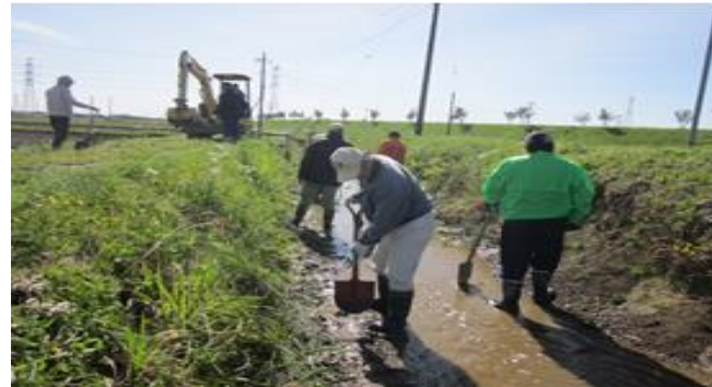
水路の泥上げ
