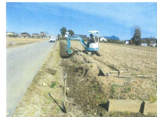
水路浚渫工事
