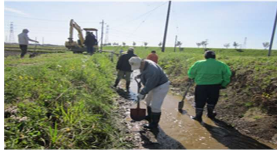
水路の泥上げ
