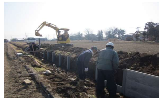
水路の大規模補修（土留設置）
