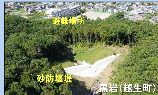
土砂災害防止施設の整備
