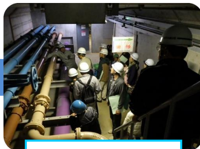
処理場の地下通路を見学
