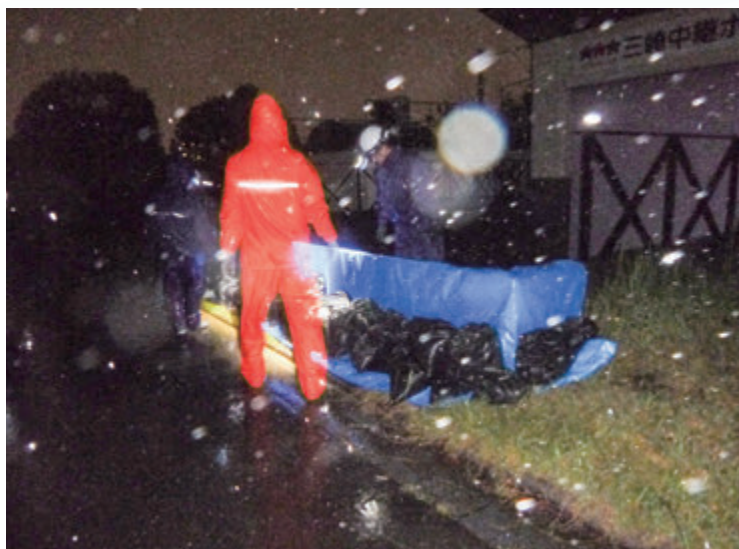
写真 - 3 台風時に三崎中継ポンプ場での土囊積み
