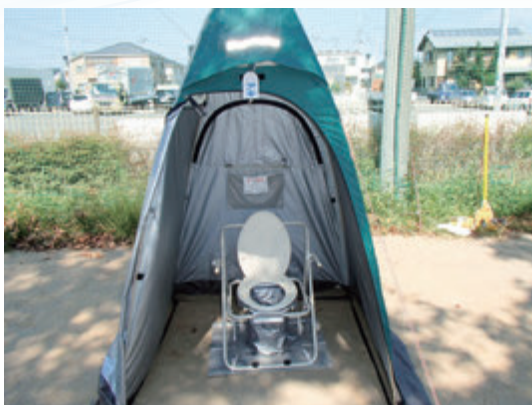
■ マンホールトイレの設置状況
