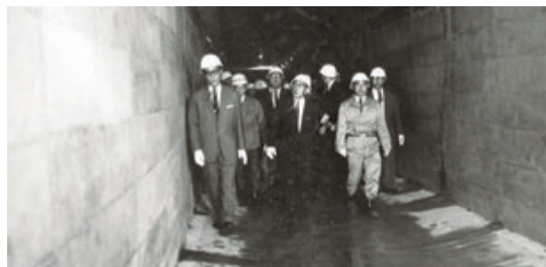
写真 - 2 完成した幹線を視察
