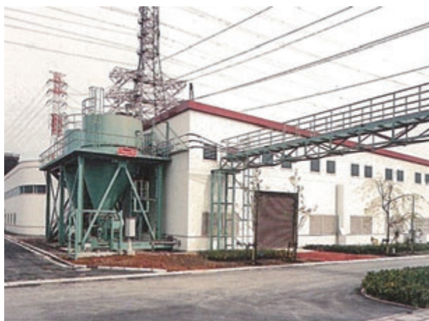
写真-3 レンガ製造センター全景（当時の様子）
