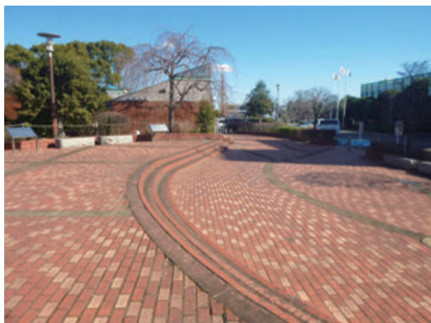
写真-1 いきいきトイレ周辺の舗装(荒川水循環センター)
