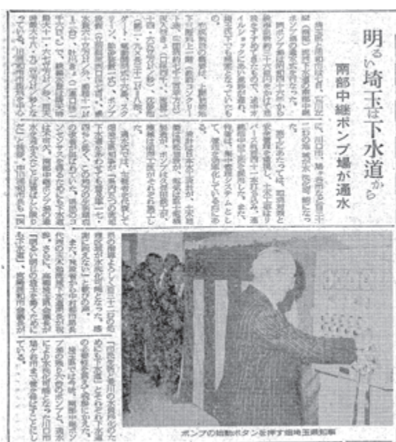
写真 - 5 南部中継ポンプ場が通水（日本下水道新聞 昭和52年4月18日付）
