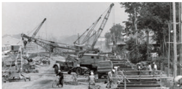
写真 - 1 重機による開削工事
