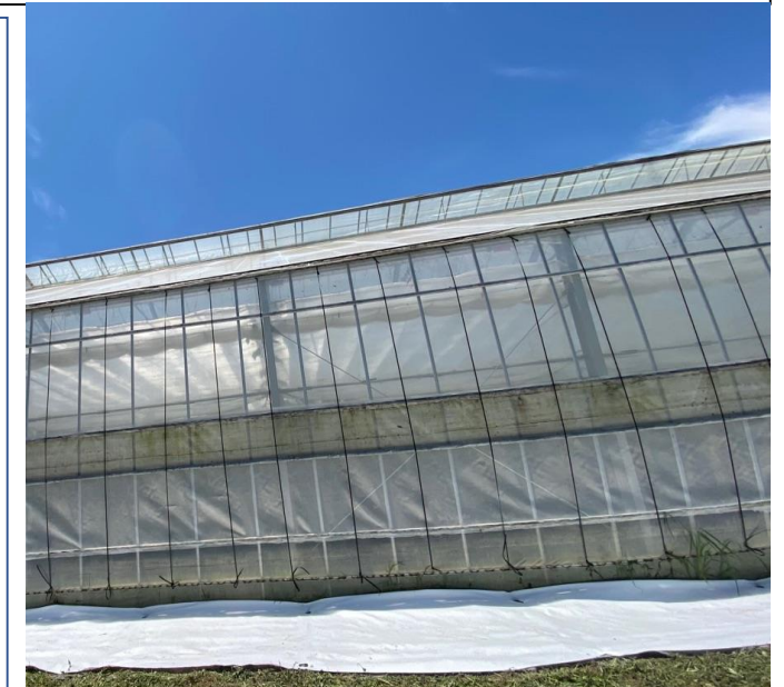
側面に防虫ネット、ハウス周辺に防虫シートを設置
