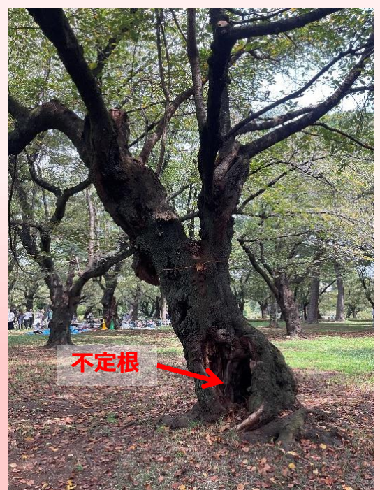
不定根が発達したサクラは、樹勢回復の見込みがあるため、保存し活用
