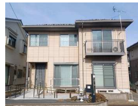
整備したグループホーム
