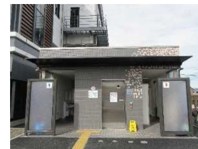
障害者対応型トイレ
