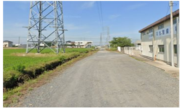
平常時の農業用水路及び道路の様子(羽生市内)
