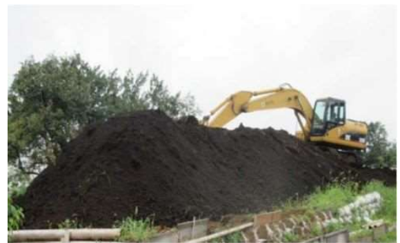
不法に盛土された農地
