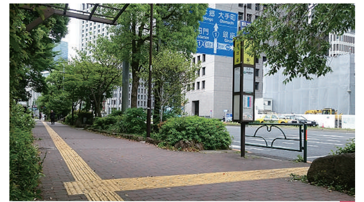
バス停までの経路を誘導する線状ブロック・点状ブロック 27
