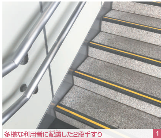
多様な利用者に配慮した2段手すり 1
