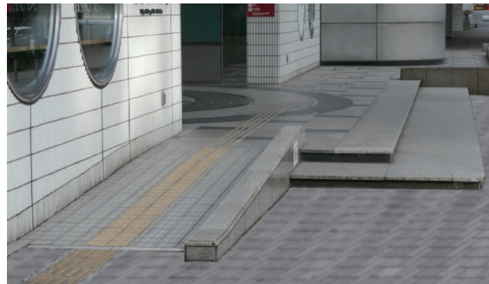
建物出入口のスロープ ① 23
