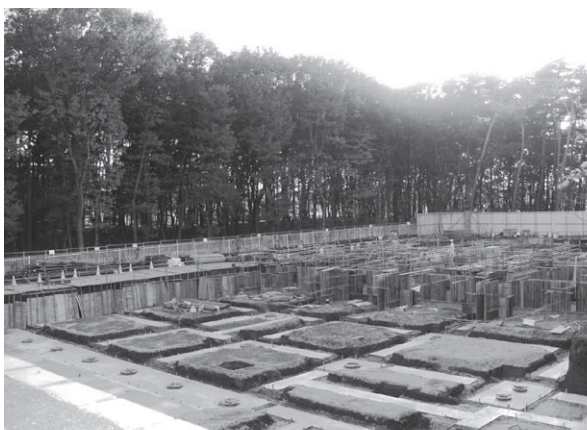
（工事中の写真）
