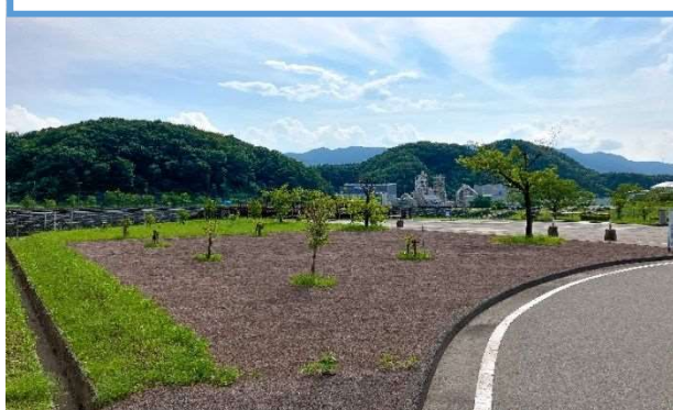
【施工事例】 雑草抑制資材
