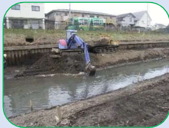
鴨川河道掘削
