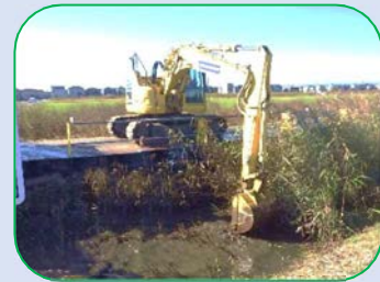
綾瀬川河道掘削
