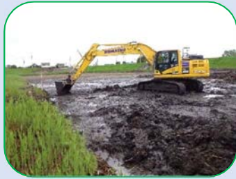
新河岸川掘削
