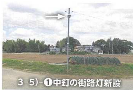
3-5)-①中釘の街路灯新設
