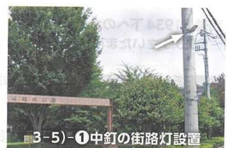
3-5)-①中釘の街路灯新設
