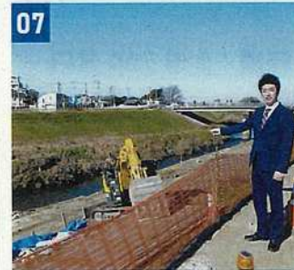
07 新河岸川護岸・堤防
