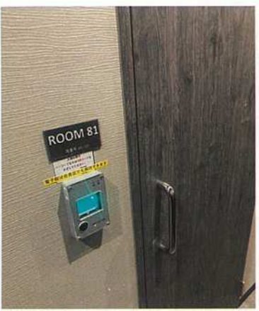
↑外部から解錠可能(立てこもり不可能)な電子ロックを採用した事業者の例。内部から、かんぬき等で封鎖することも不可能な形状。
