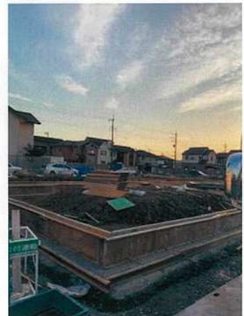
仮庁舎建設現場 (R4. 12 撮影)
