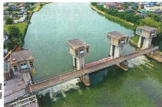
③ 補1 古利根堰(地域住民の安全保障と農業用水の安定供給を図るため、堰の耐震化対策工事を嫉視しています)
