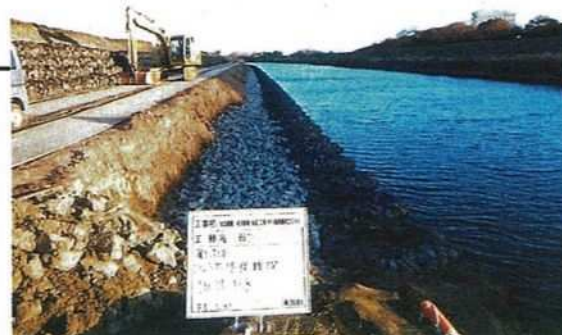
① 中川(河川改修)
