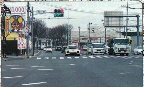
④ 国道463号の立体交差化 松郷交差点
