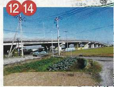
羽生跨線橋(羽生栗橋線)耐震補強
