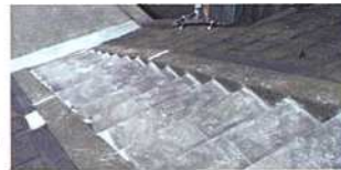
大久保五関地区、鴨川堤防階段の補修完了
