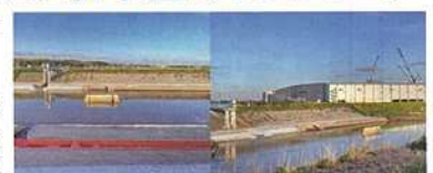
市野川の城南新宿橋下流で整備工事をする新たな諏訪堰の現在の様子
