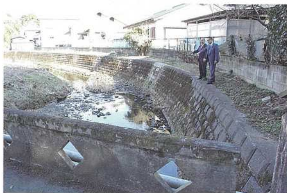
▲河川拡幅が予定されている境橋下流
