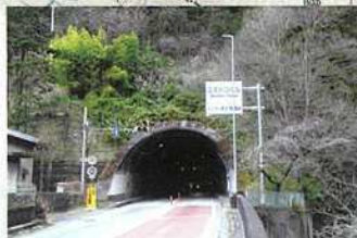
補③ 正丸トンネル
