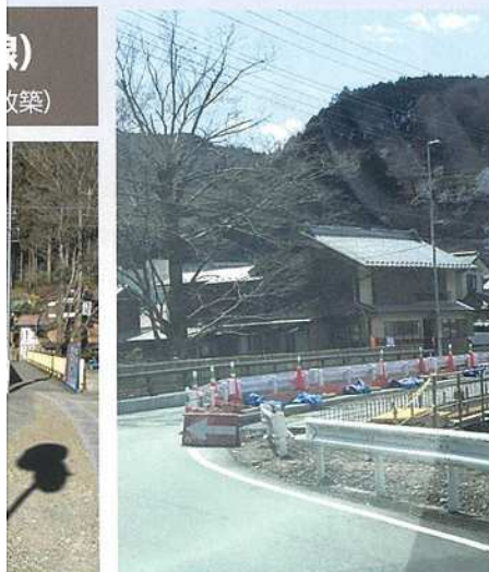
下加治高架橋 (飯能寄居線) 橋りょう修繕 (橋脚補強)
