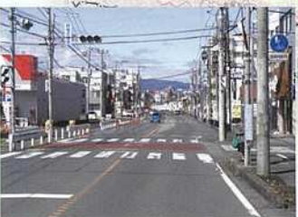
④ 国道299号(道路改築)
