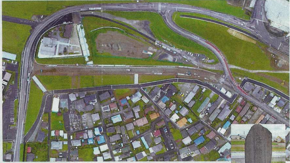
《令和4年8月18日撮影／国土交通省利根川上流河川事務所提供》
