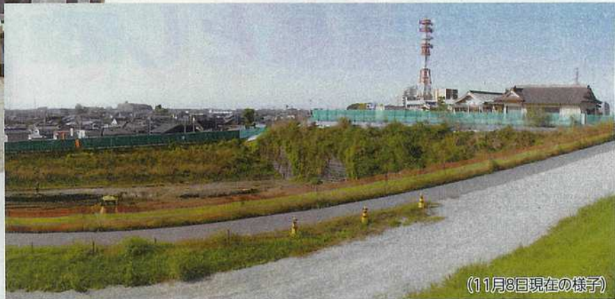
▲堤防の外側にあった八坂神社は嵩上げされた堤防の上へと移築されました。今後は八坂神社前の堤防法面の嵩上げ及び道路の付け替えなどが行われ、完成は令和6年の予定です。
