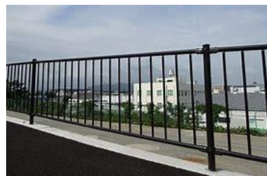
景観色の転落防止柵(ダークブラウン)
