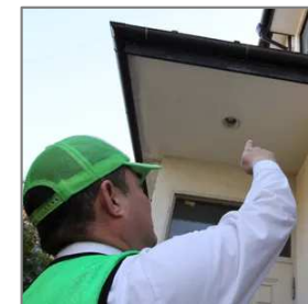
見回り時の目視点検の様子
