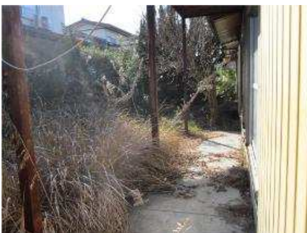
雑草が繁茂した空き家
