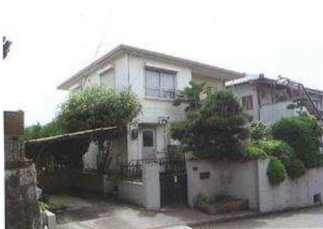
まだ使用できる空き家
