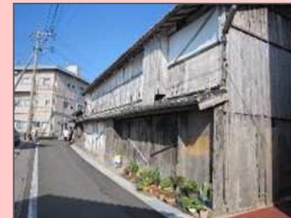
空き家の除却
