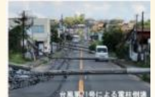
台風第21号による電柱倒壊
