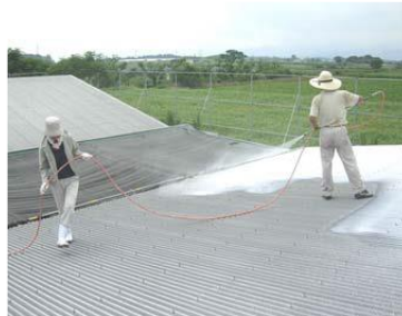
石灰の吹き付け（宮崎県）
