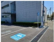
上里町役場EV充電スタンド
