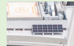
太陽光パネル
