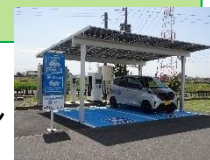
充電ステーション
